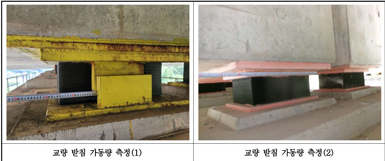
【사진 17.3.16】 교량받침 이동량 측정
