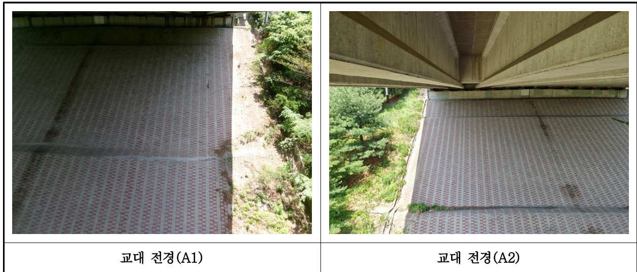
【사진 17.3.8】 교대 전경
