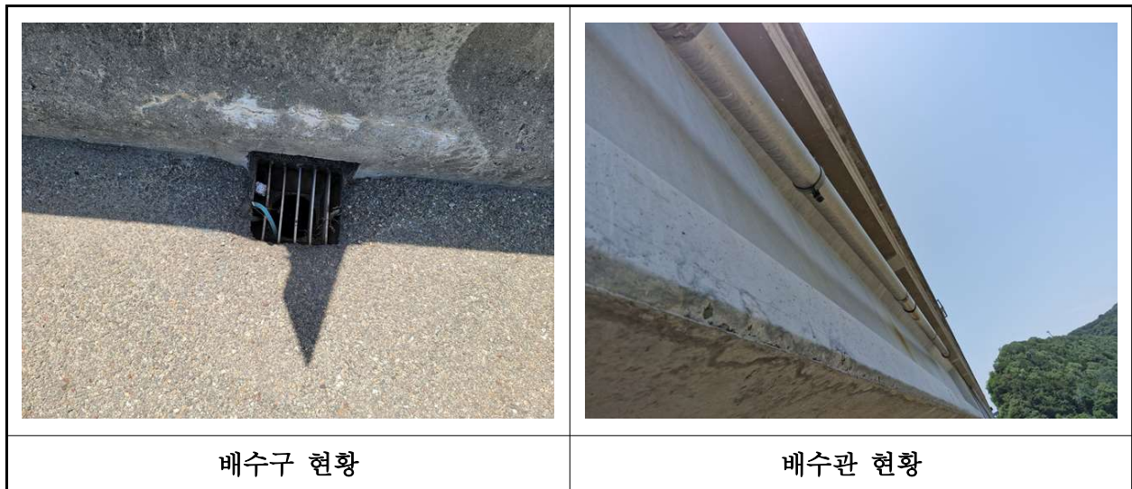
【사진 17.3.22】 배수시설 전경
