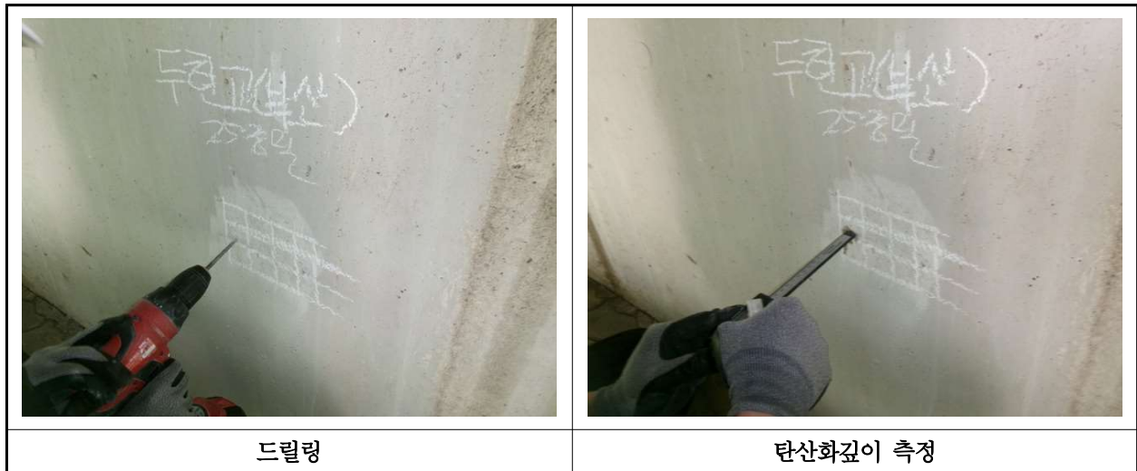
【사진 17.4.3】 탄산화 깊이 측정 현장사진
