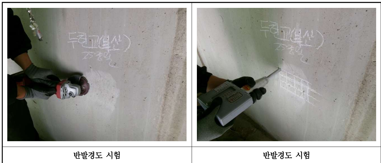
【사진 17.4.2】 반발경도시험 현장사진
