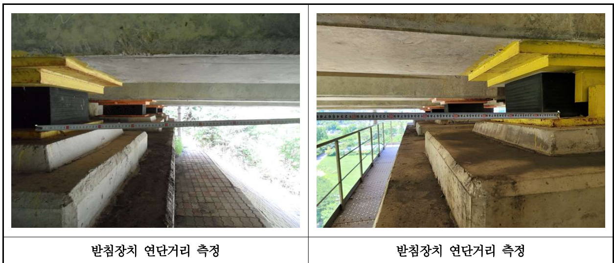
【사진 17.3.15】 교량받침장치 연단거리측정
