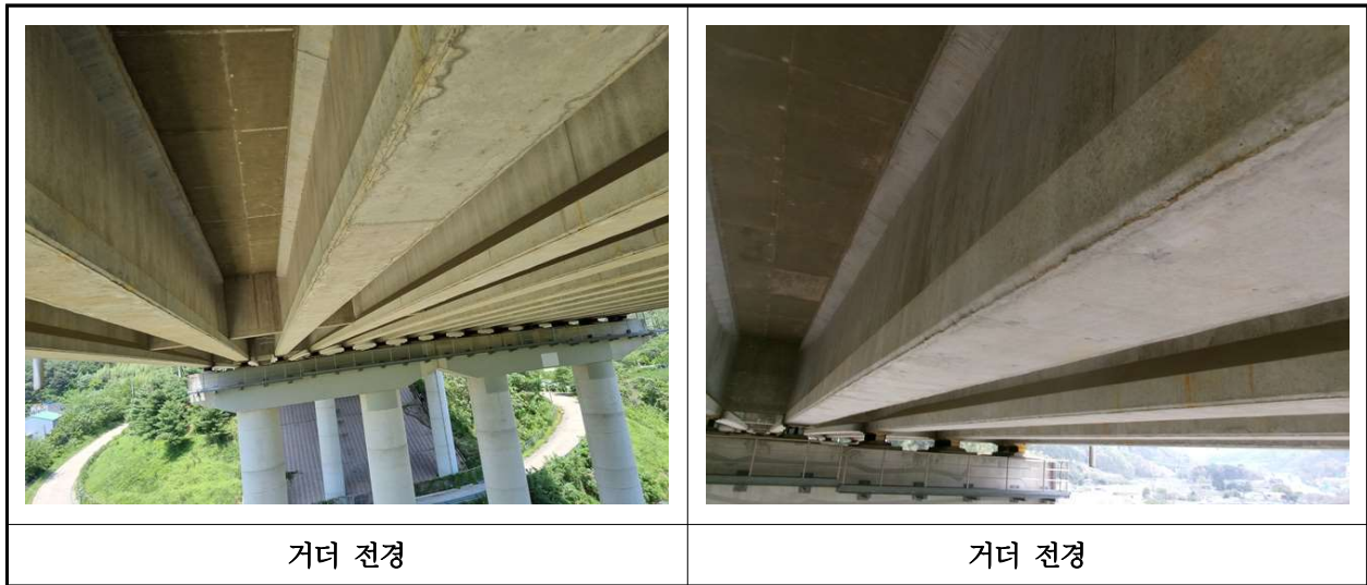
【사진 17.3.4】 거더 전경
