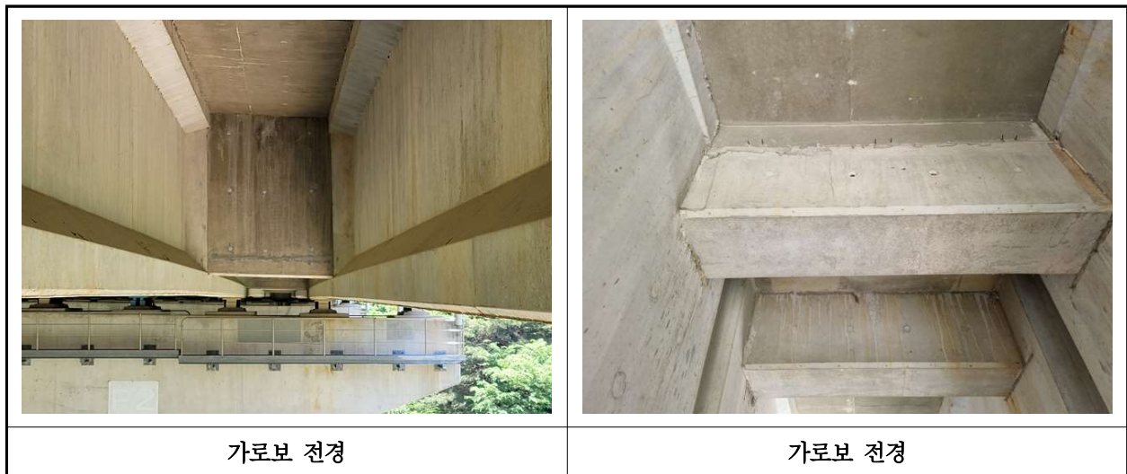
【사진 17.3.6】 가로보 전경
