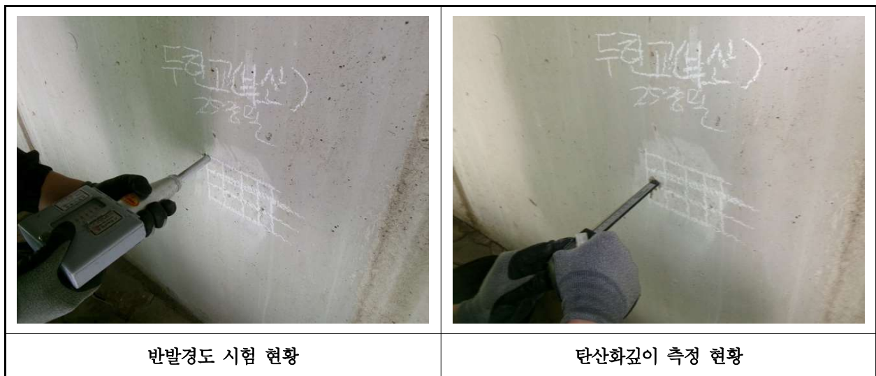
【사진 17.4.1】 콘크리트 내구성조사 현황
